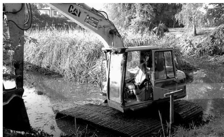
Hůstík – zemní práce
