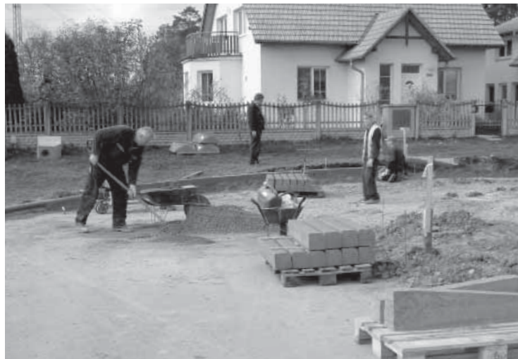
Místní komunikace ul. Stanoviska
