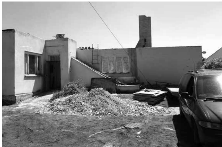
Demolice budovy obecního úřadu
