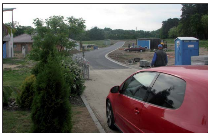
Stavební obvod Dřínovec
