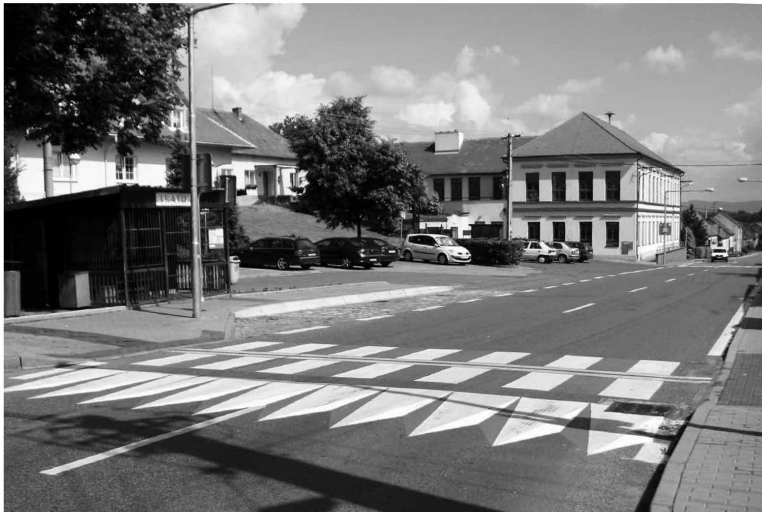
Nový přechod a chodníky u stánku
