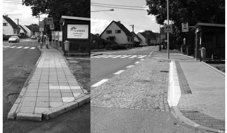
Nástupiště autobusové zastávky před rekonstrukcí a po rekonstrukci
