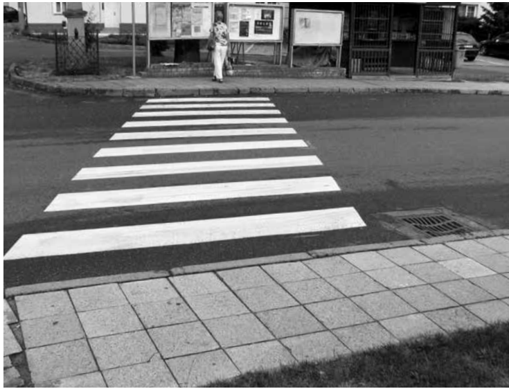
Původní přechod a chodníky u stánku
