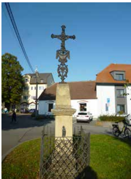
Kříž na návsi před opravou
