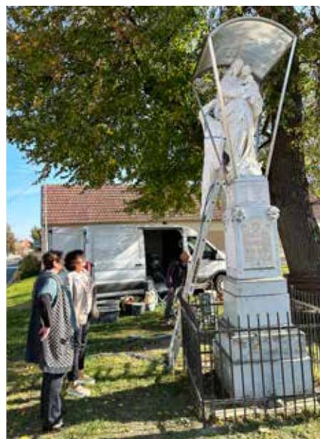
Socha Panny Marie Růžencové před opravou
