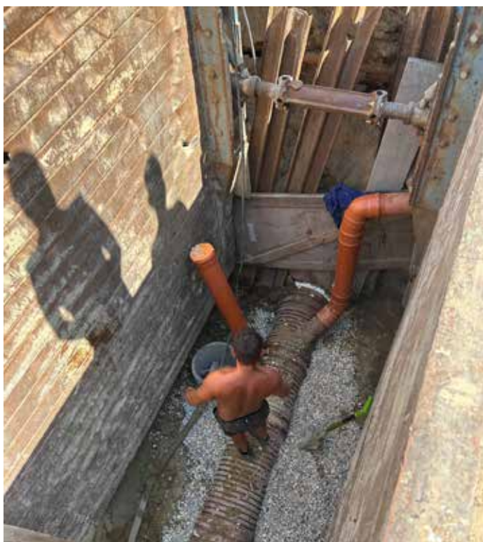
Jezérka - oprava kanalizace
