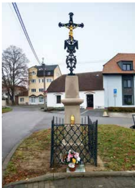
Kříž na návsi po opravě
