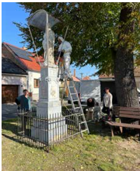
Socha Panny Marie Růžencové před opravou
