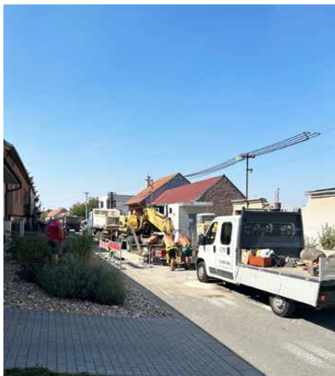
Jezérka - oprava kanalizace
