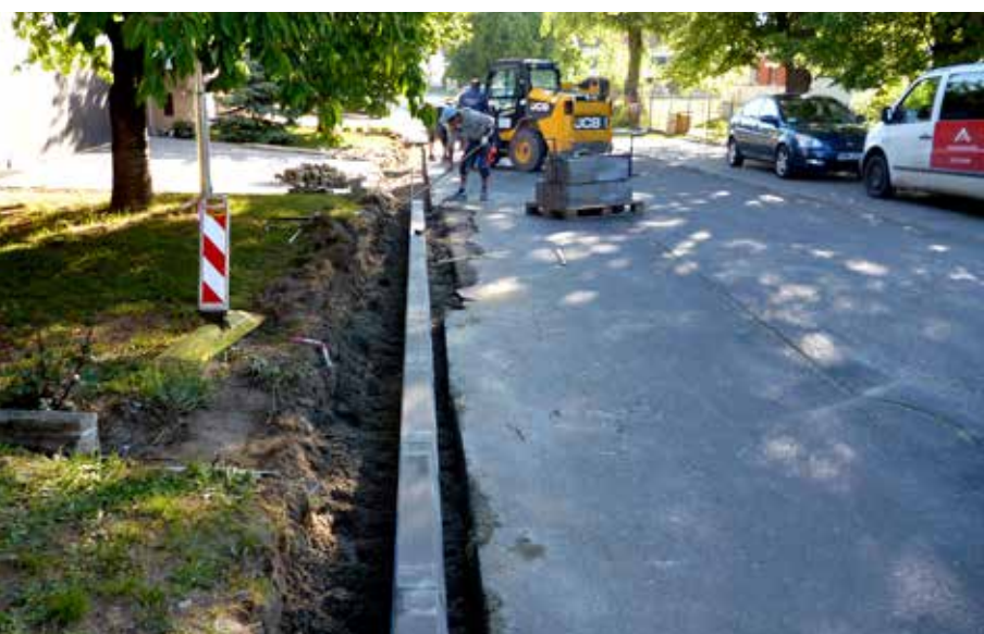
Rekonstrukce MK ul. U Větráku
