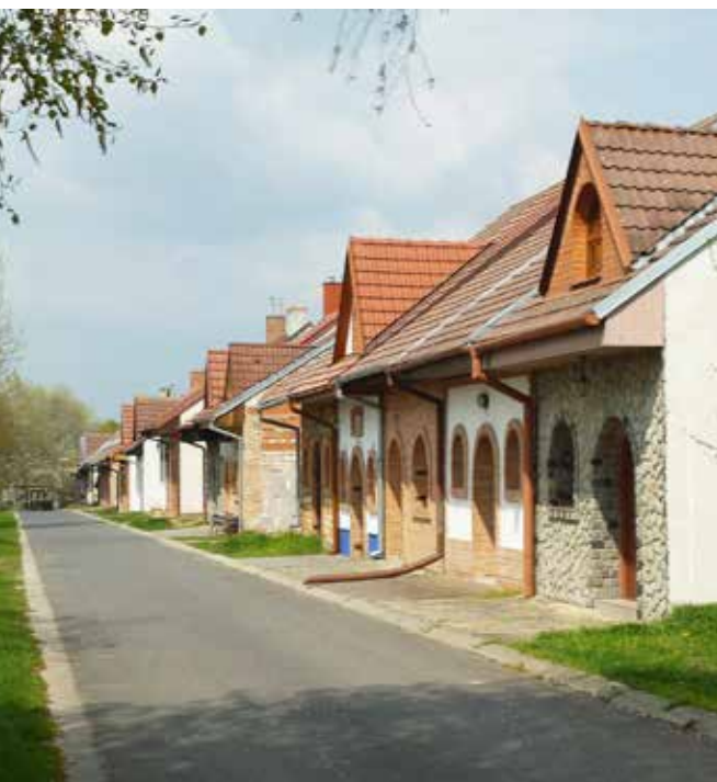
Žlábky čekají na nový vodovod
